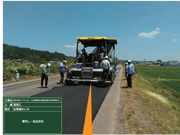
新しいアスファルト層5cmを形成します
