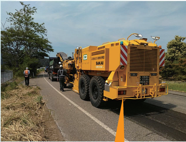
路面切削機にて 傷んだ舗装部分5cmを取除きます
